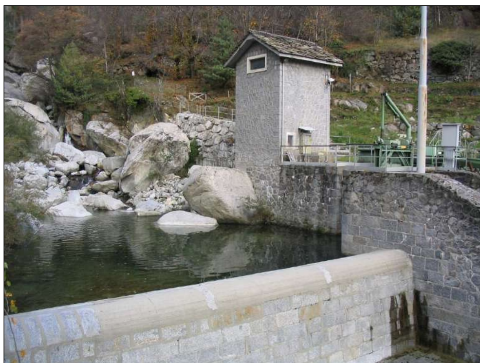
Foto 2 - Opera di presa sul Torrente Piantonetto
