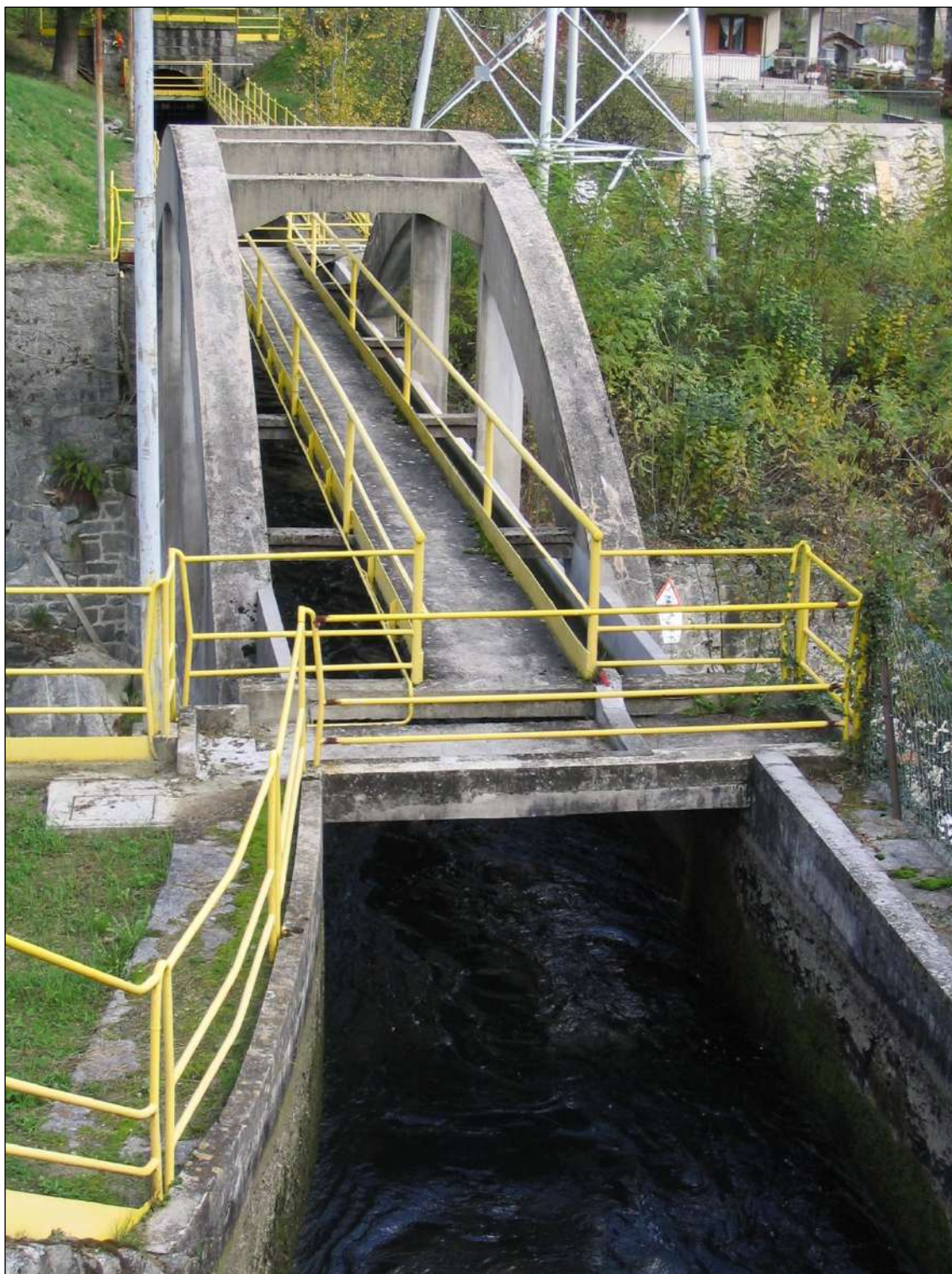
Foto 3 - Canale di derivazione a valle dello scarico della centrale di Rosone e ponte canale sul torrente Piantonetto
