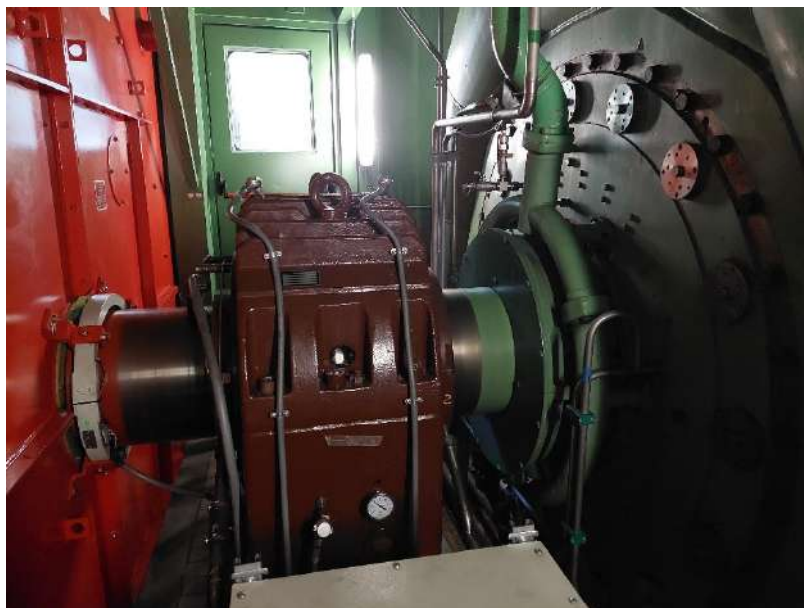
Foto 11 – Dettaglio accoppiamento turbina – generatore
