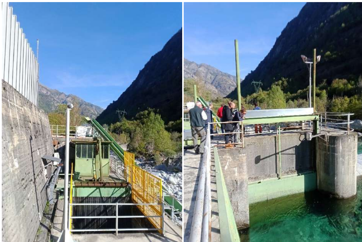
Figura 5 – Sgrigliatore e paratoia sghiaiatrice in corpo traversa
