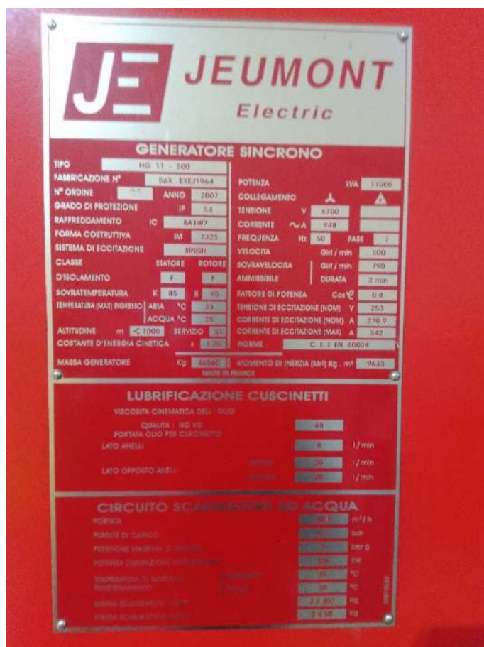
Figura 21 – Targa del generatore di ciascuno dei due gruppi
