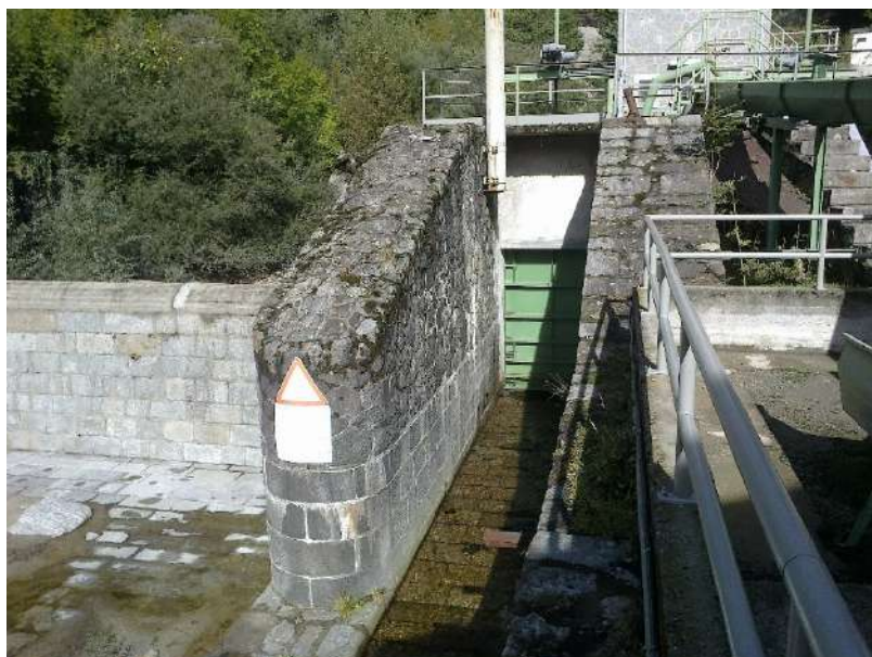
Figura 9 – Opera di presa sul torrente Piantonetto
