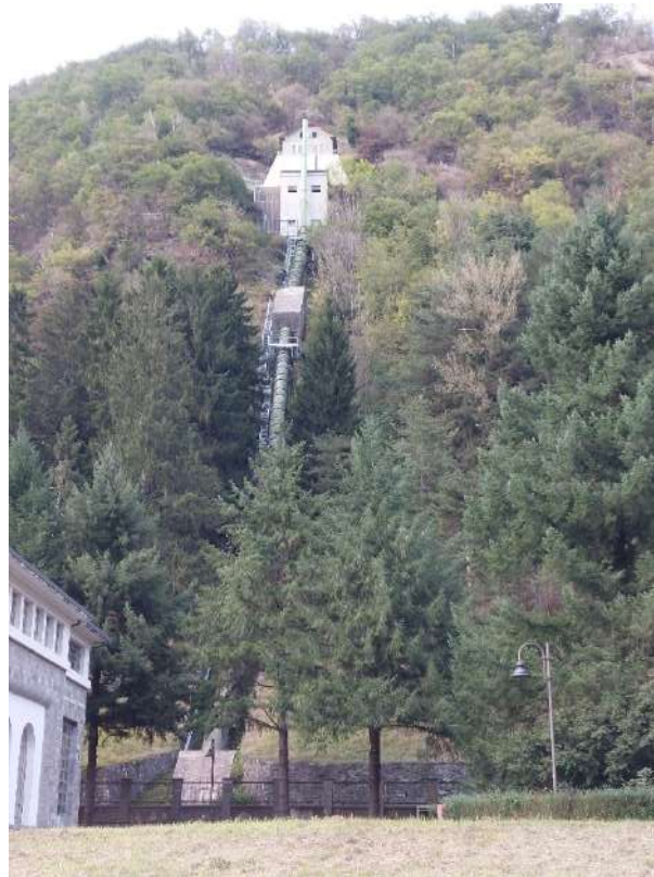
Figura 17 – Vasca di carico e condotta forzata dell'impianto di Bardonetto
