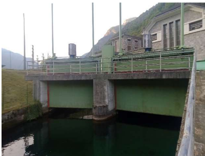
Figura 22 – Paratoie di sezionamento dello scarico della centrale
