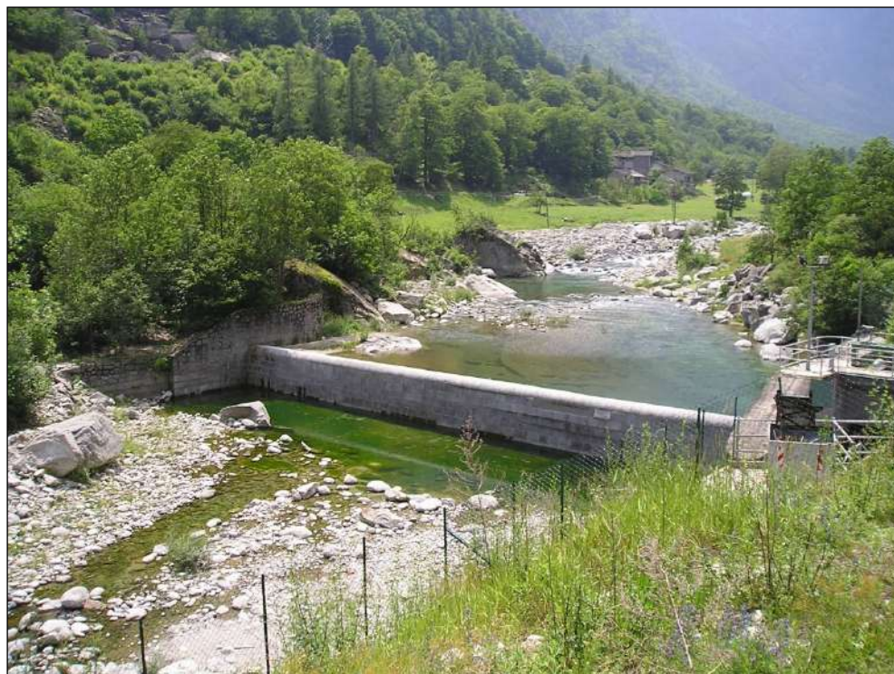
Foto 1 - Opera di presa sul Torrente Orco
