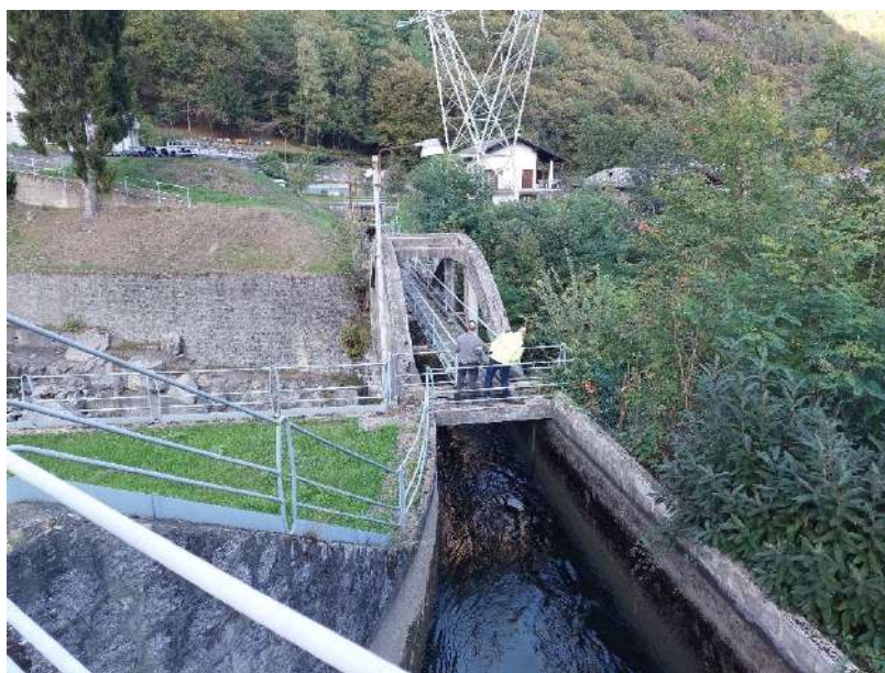
Figura 7 – Ponte canale sul torrente Piantonetto del canale di derivazione a valle dello scarico della centrale di Rosone. Superato il t. Piantonetto le portate defluiscono in galleria sino alla vasca di carico di Bardonecchio
