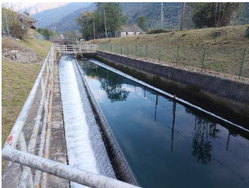
Figura 23 – Canale di scarico di centrale e sfioratore triangolare
