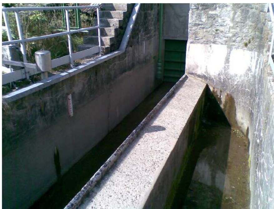
Figura 27 – Canale derivatore, vista del sensore di misura
