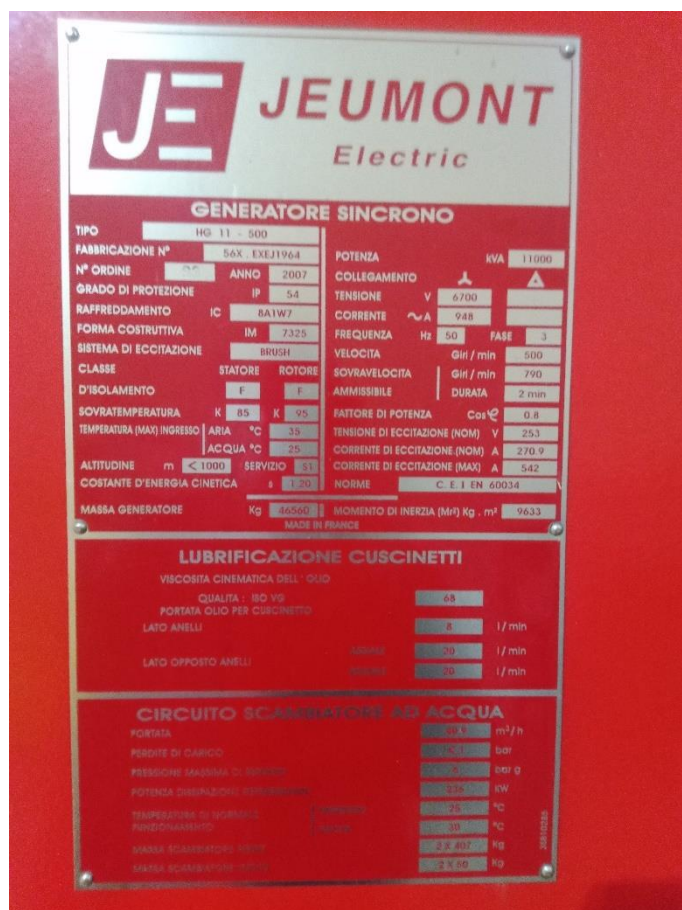
Figura 2 – Targa del generatore di ciascuno dei due gruppi
