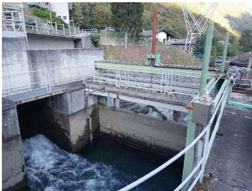
Figura 6 – Scarico della centrale di Rosone e paratoia di rilascio delle portate al torrente Piantonetto
