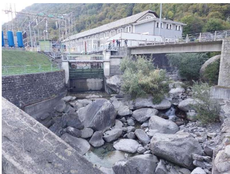
Figura 12 – Ponte canale sul torrente Piantonetto e paratoia di scarico in alveo
