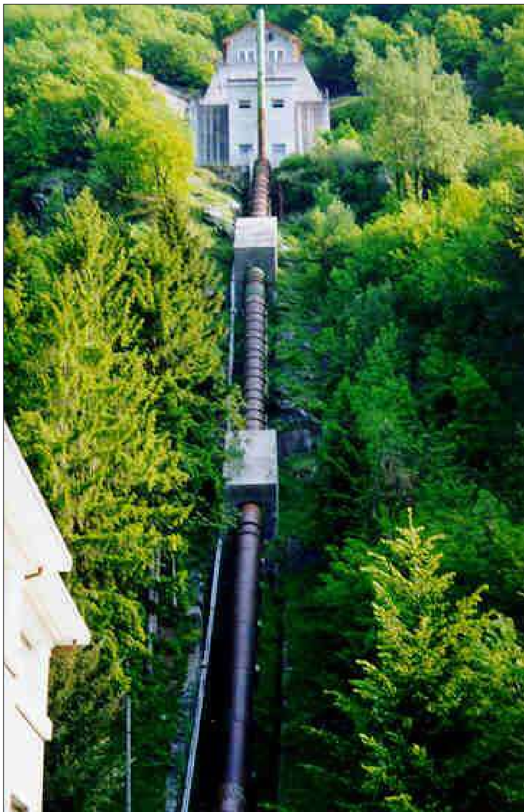
Foto 4 - Camera di carico e condotta forzata
