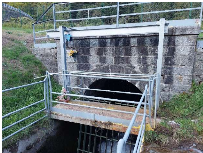
Figura 13 – Imbocco del canale di derivazione in galleria a valle del ponte canale sul torrente Piantonetto
