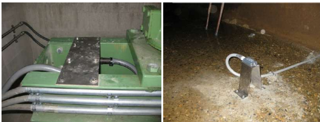
Figura 25 – Misuratore di portata (a sx) e misuratore di velocità (a dx)
