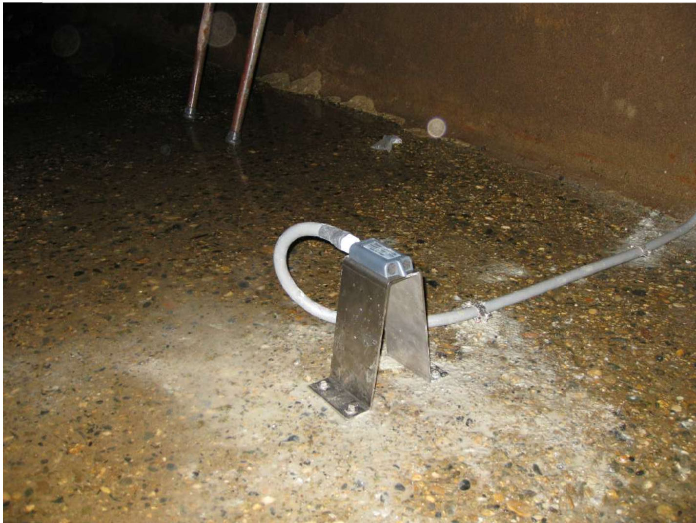
FOTO 3 - INSTALLAZIONE MISURATORE DI VELOCITA'
