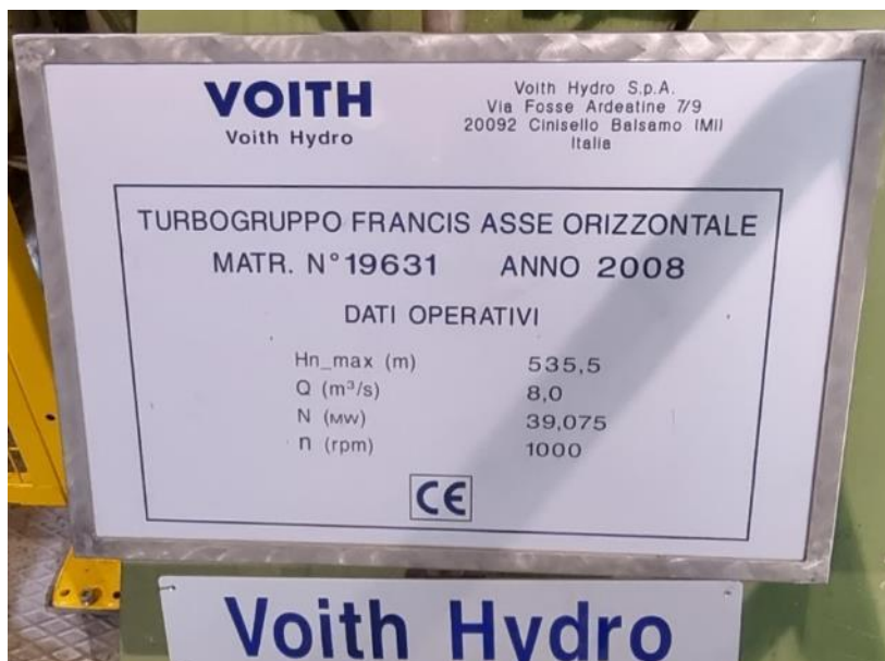
Figura 12 – Targa della turbina dell'impianto Valsoera-Telesio
