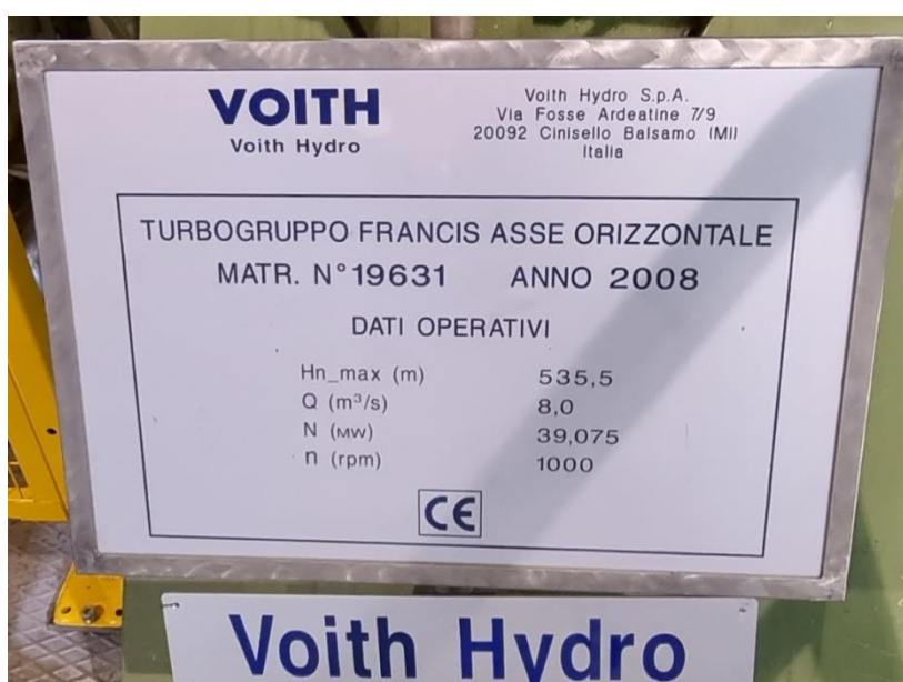
Figura 1 – Targa della turbina dell'impianto Valsoera - Telesio
