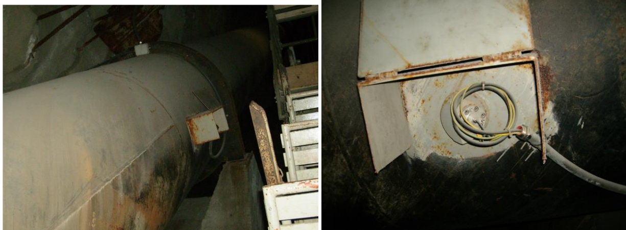
Figura 16 – Viste di dettaglio del misuratore di tipo Rittmeyer
