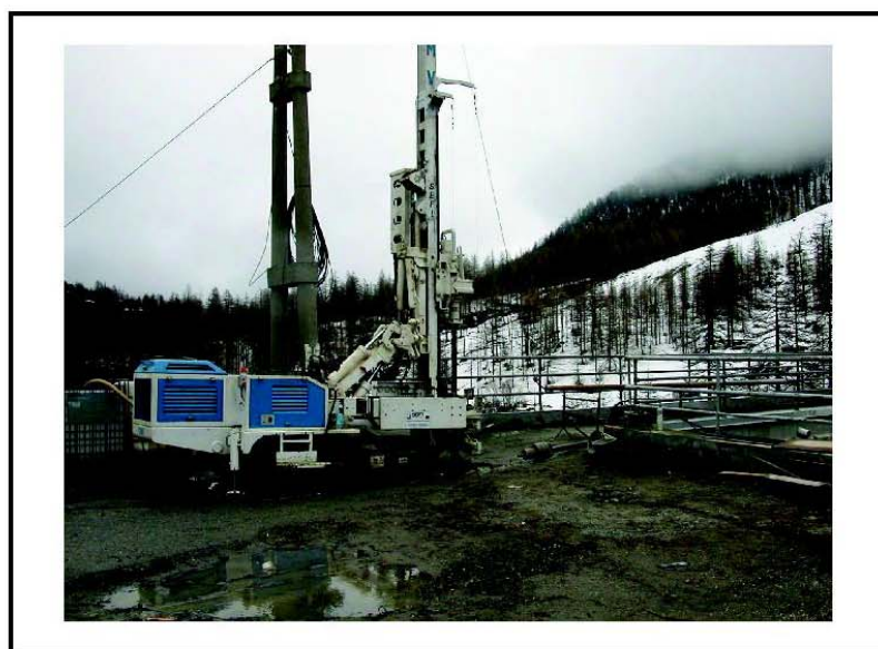
Foto 8: Posizionamento sondaggio S1 (sbarramento – spalla sinistra).
