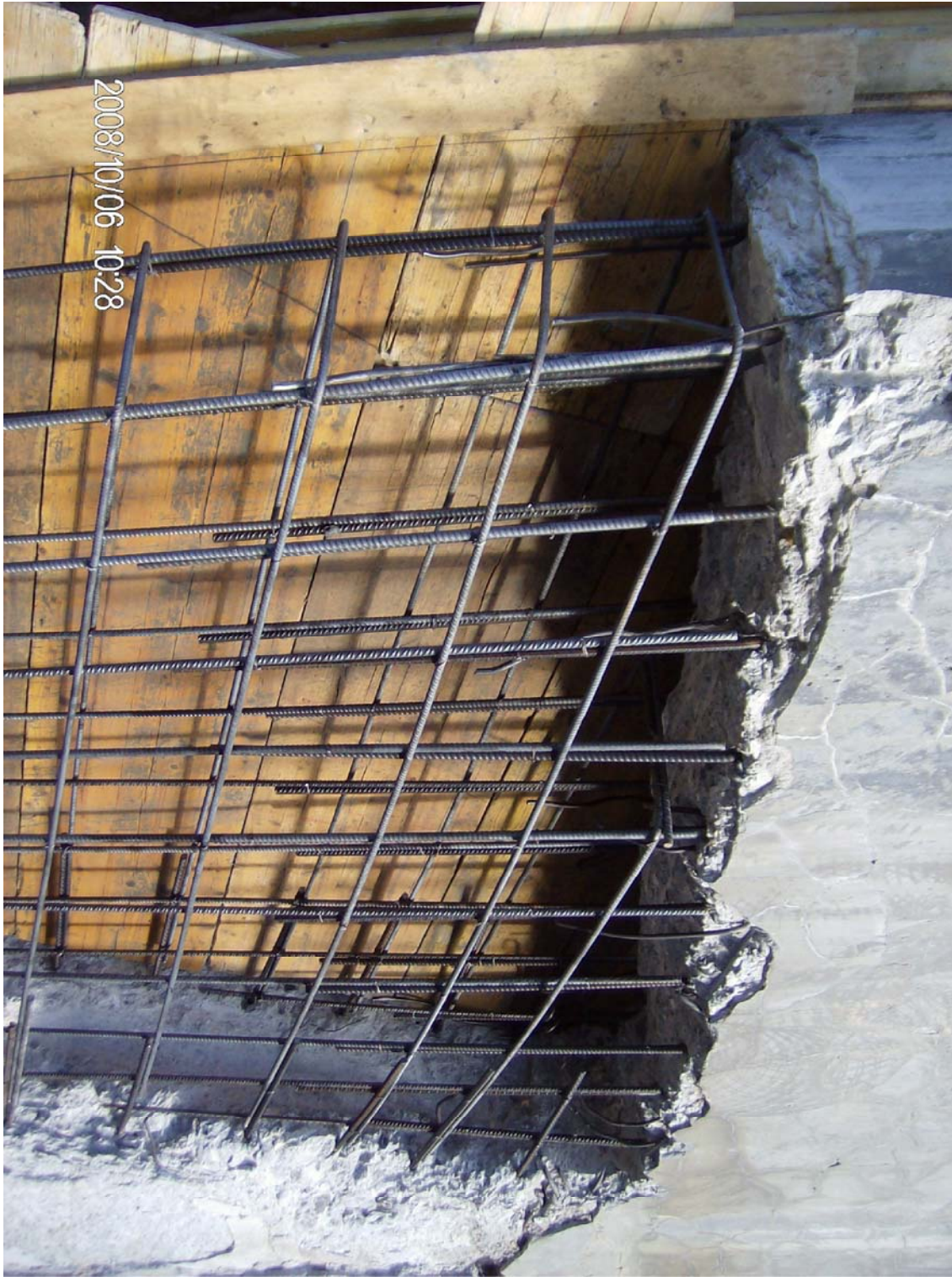
PARTICOLARE DELLE ARMATURE DEI SETTI ESTERNI
