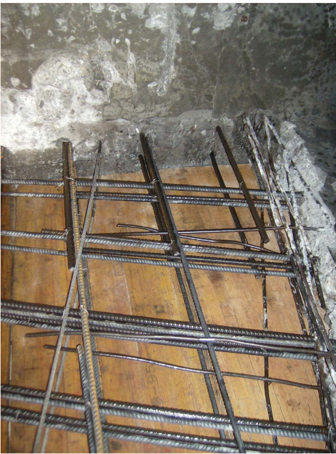
PARTICOLARE DEGLI ANCORAGGI SULLA PARETE DEI SIFONI IN CORRISPONDENZA DEI SETTI INTERNI
