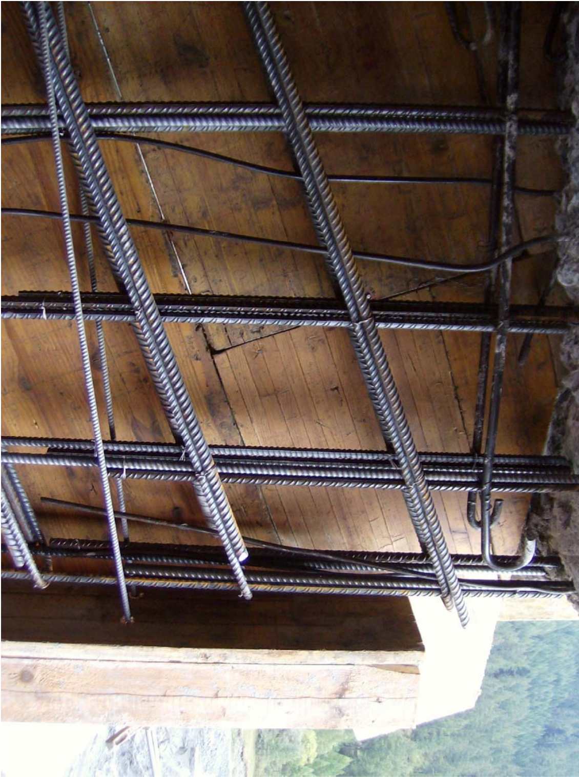
PARTICOLARE DELLE ARMATURE DEI SETTI INTERNI
