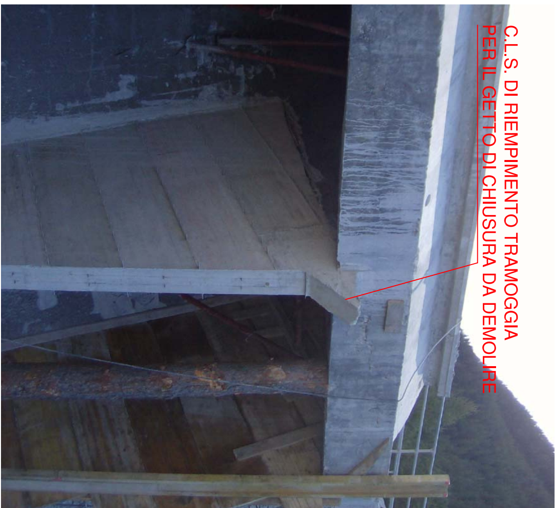
VISTA DEL C.L.S. RIMASTO NEL CASSEGGIO-TRAMOGGIA DA DEMOLIRE
